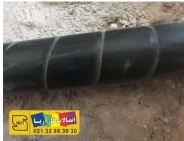
این مسئله بیشتر برای لوله‌های توکار ضرورت دارد. در صورت توکار بودن لوله‌ها بهتر است حتماً از چسب و نوارهایی استفاده شود که تاریخ مصرف طولانی داشته و از یک برنده مرغوب انتخاب شده باشند.
