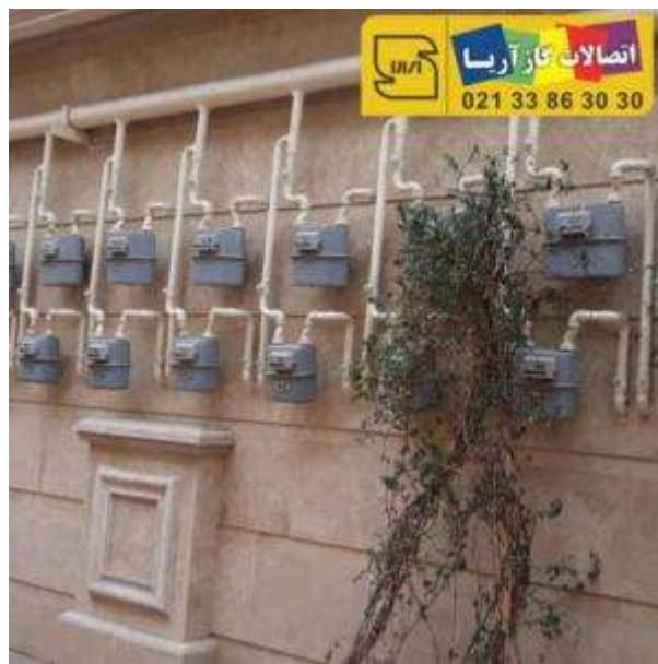
پس از اجرای **لوله کشی گاز روکار** و تایید آن، نیاز به نصب کنتور گاز می باشد. [انواع کنتور گاز](#) یکی از ابزارهای مخصوص اندازه گیری جریان هستند. می توان به وسیله آنها میزان و حجم سوخت گازی را اندازه گیری نمود. برای آنکه عدد آن کاملاً دقیق باشد، باید از قبل دما، فشار و گرمای گازی اندازه گیری شده باشد.
