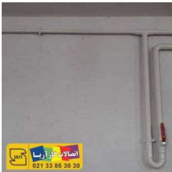
از نکات مثبت **لوله کشی گاز روکار** آن است که در صورت نشتی، پوسیدگی و ترک می‌توان با سرعت بیشتری مسئله را رفع نمود. با استفاده از لوله‌های قوی و صحیح و بررسی سالانه آن‌ها، می‌توان طول عمر مصرف را افزایش داد. همچنین، نصب **لوله کشی گاز روکار** در ساختمان‌های تمام شده یا قدیمی راحت‌تر خواهد بود و نیاز به تخریب گسترده دیوارها و مشکلاتی از این قبیل، نخواهد داشت.
